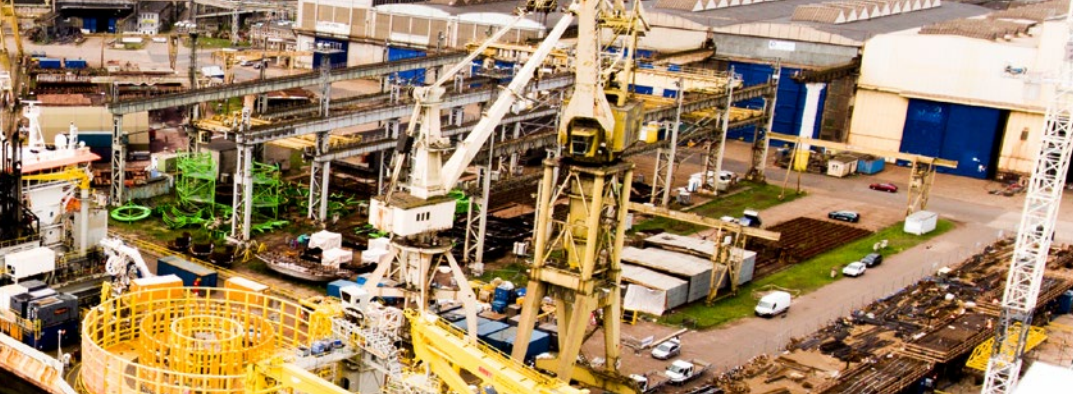
Fot. Vestas Wind Systems A/S
